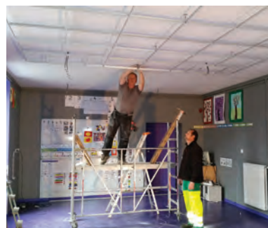
Pose d'un plafond anti-bruit dans une classe de l'école maternelle
