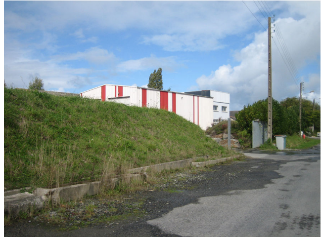
Vue sur l'ancien bâtiment de Dentressangle
