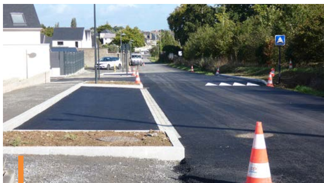
• Sécurisation de la rue du Lavoir
