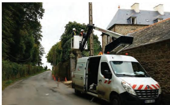
**D'importants travaux d'éclairage public** sur un linéaire total de 900 mètres ont été réalisés en 2017, avec l'aide du SDE35 (syndicat d'électrification d'Ille et vilaine). Nous avons opéré des remplacements et des créations de points lumineux sur des rues complètes, tout ceci avec une technologie à LED qui permet de baisser la consommation par 4 tout en augmentant la qualité d'éclairage :
