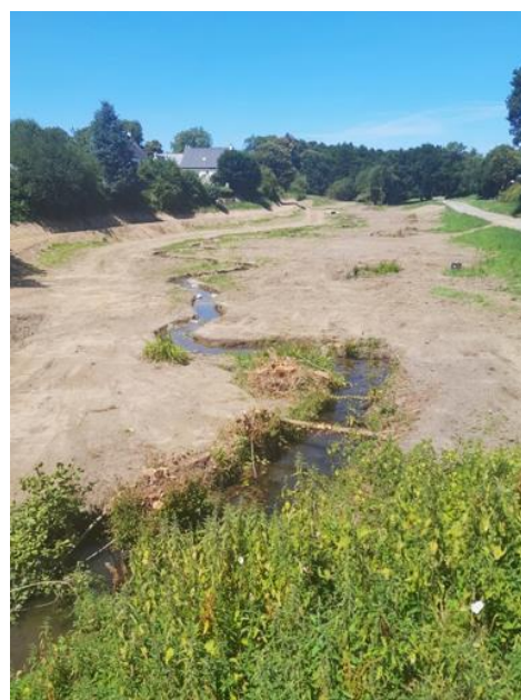
Le Ruisseau de la Hirlais après travaux
