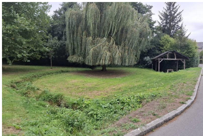
Le lavoir (après travaux)
