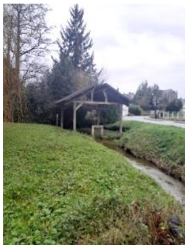
Le lavoir (avant travaux)
